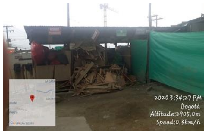
Ilustración 20: Puntos de acopio de RCD instalados en el proyecto Jardín Infantil Ciudadela Bolonia Jardín Infantil Ciudadela Bolonia. PIN 16336.
