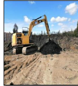
Imagen 4 – Retroexcavadora de oruga.
