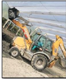
Imagen 2 – Retroexcavadora de llanta
