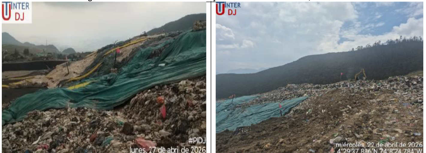
Imágenes: Instalación Métodos Ahuyentamiento Aves RSDJ, abril 2026
