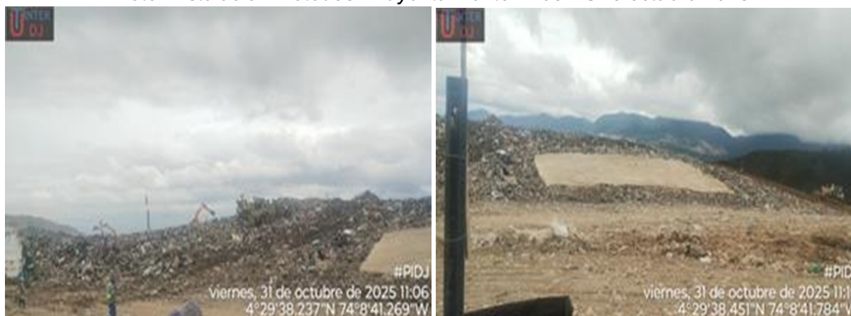
Foto. Instalación Métodos Ahuyentamiento Aves RSDJ octubre 2025
