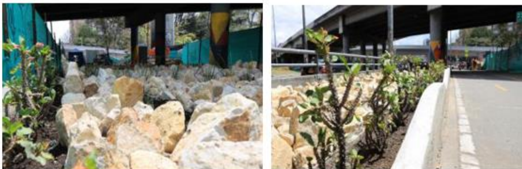
Figura 25 Intervención puentes Calle 68 y Carrera 15
