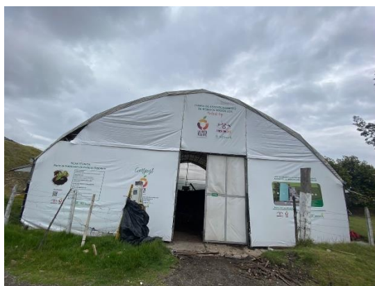
Figura 15 Mejoramiento de las cubiertas y laterales de la planta
