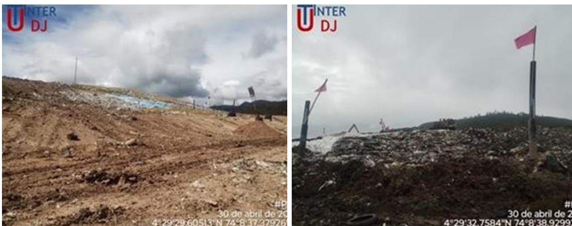
Foto No. 10-1. Instalación Métodos Ahuyentamiento Aves RSDJ abril 2025
