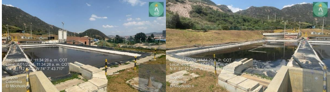
Fuente: UAESP visita de campo 04 de enero del 2024.
