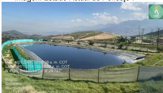
Imagen. Estado Actual de Pondaje 7
