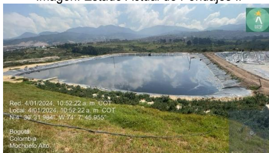
Imagen. Estado Actual de Pondajes II
