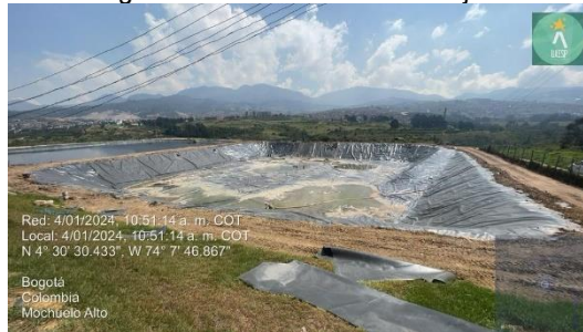
Imagen. Estado Actual de Pondajes II
