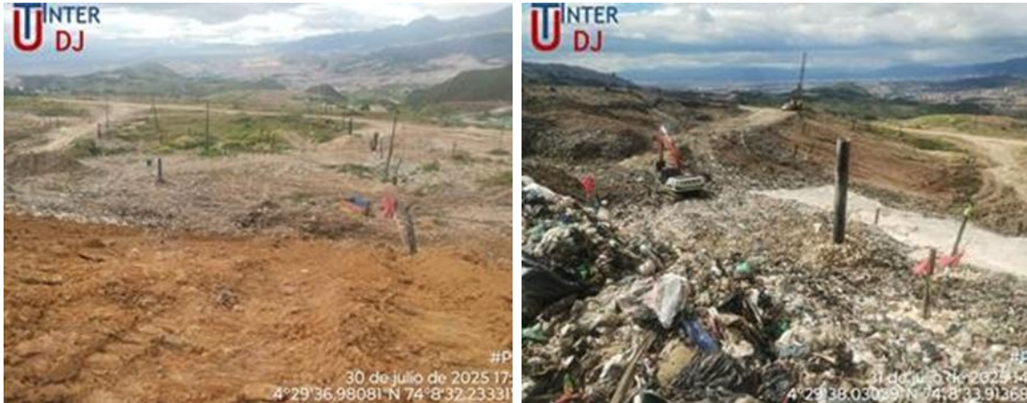
Foto No. 10-1. Instalación Métodos Ahuyentamiento Aves RSDJ , julio 2025
