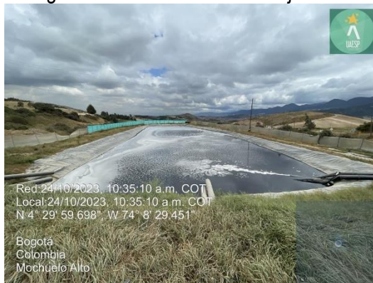
Imagen. Estado Actual de Pondaje VII
