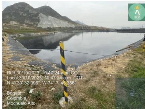
Imagen. Estado Actual de Pondajes II
