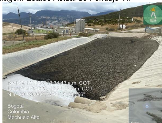
Imagen. Estado Actual de Pondaje VII
