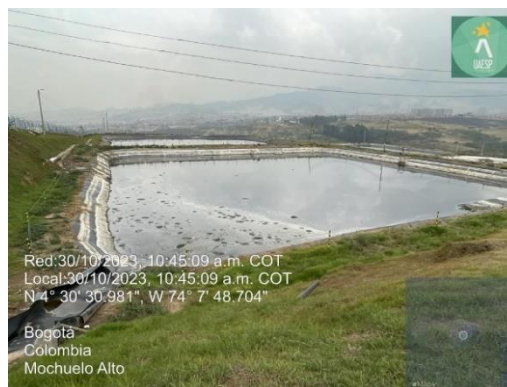
Imagen. Estado Actual de Pondajes II
