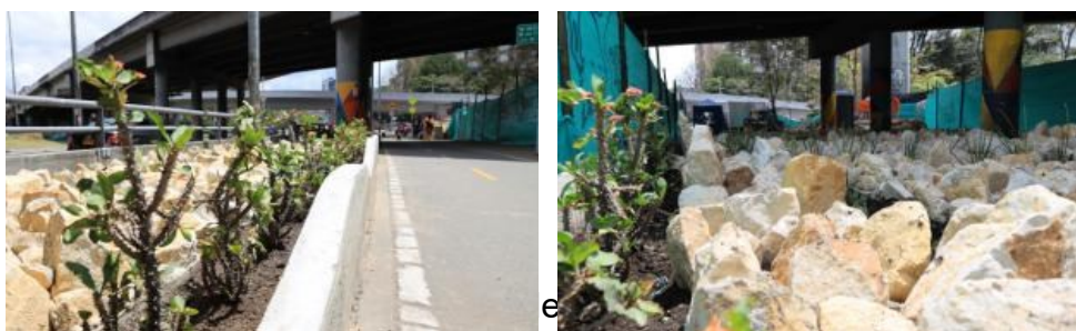
Figura 26 Intervención puentes Calle 68 y Carrera 15
