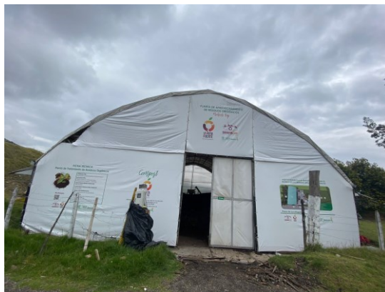
Figura 17Mejoramiento de las cubiertas y laterales de la planta
