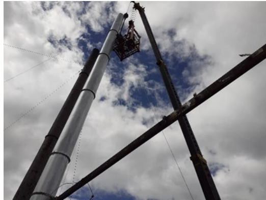
Figura 10 Montaje de chimenea C. Norte
