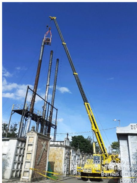
Figura 9 Desmontaje de chimeneas C. Norte
