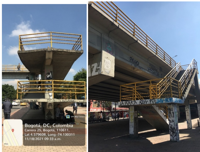
Ilustración 16. Ejemplo fotografía evidenciar características puente. Elaboración propia
