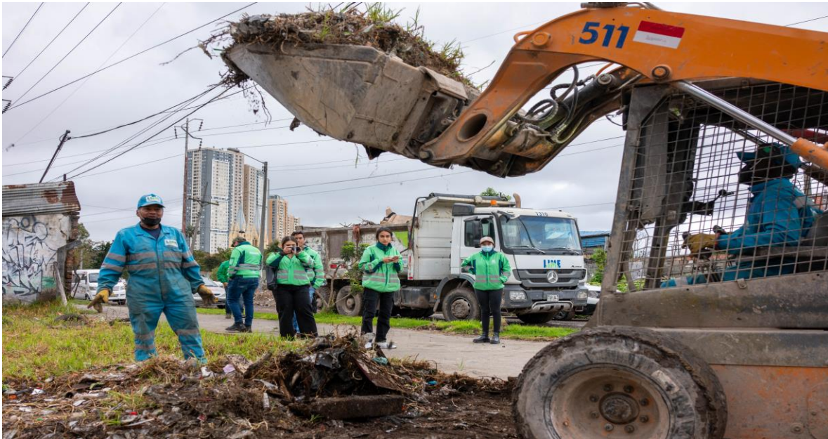
Operativo interinstitucional en la localidad de Mártires, para la recuperación de un punto crítico. 2025.
