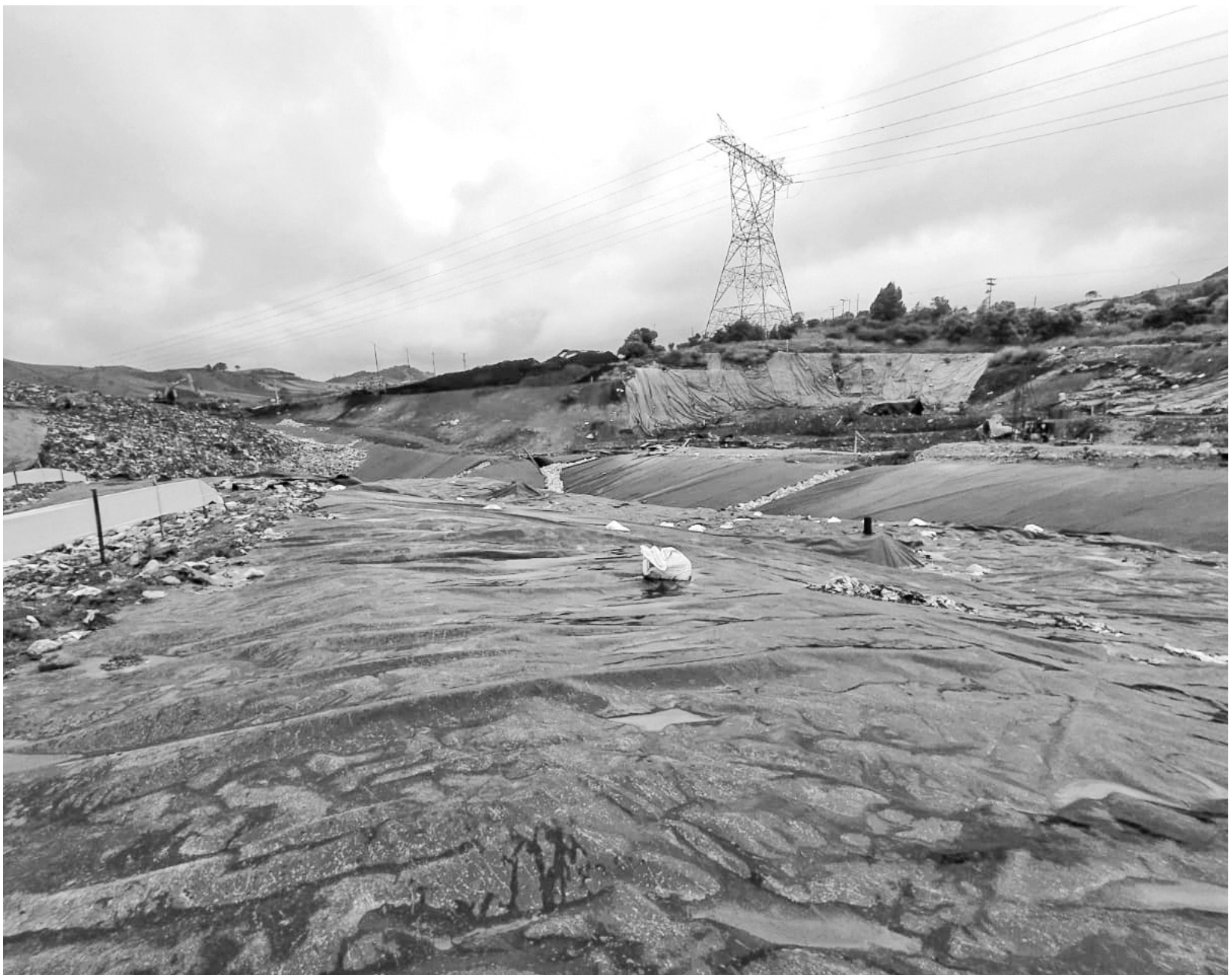
» Instalación de geomembrana con termosellado.
