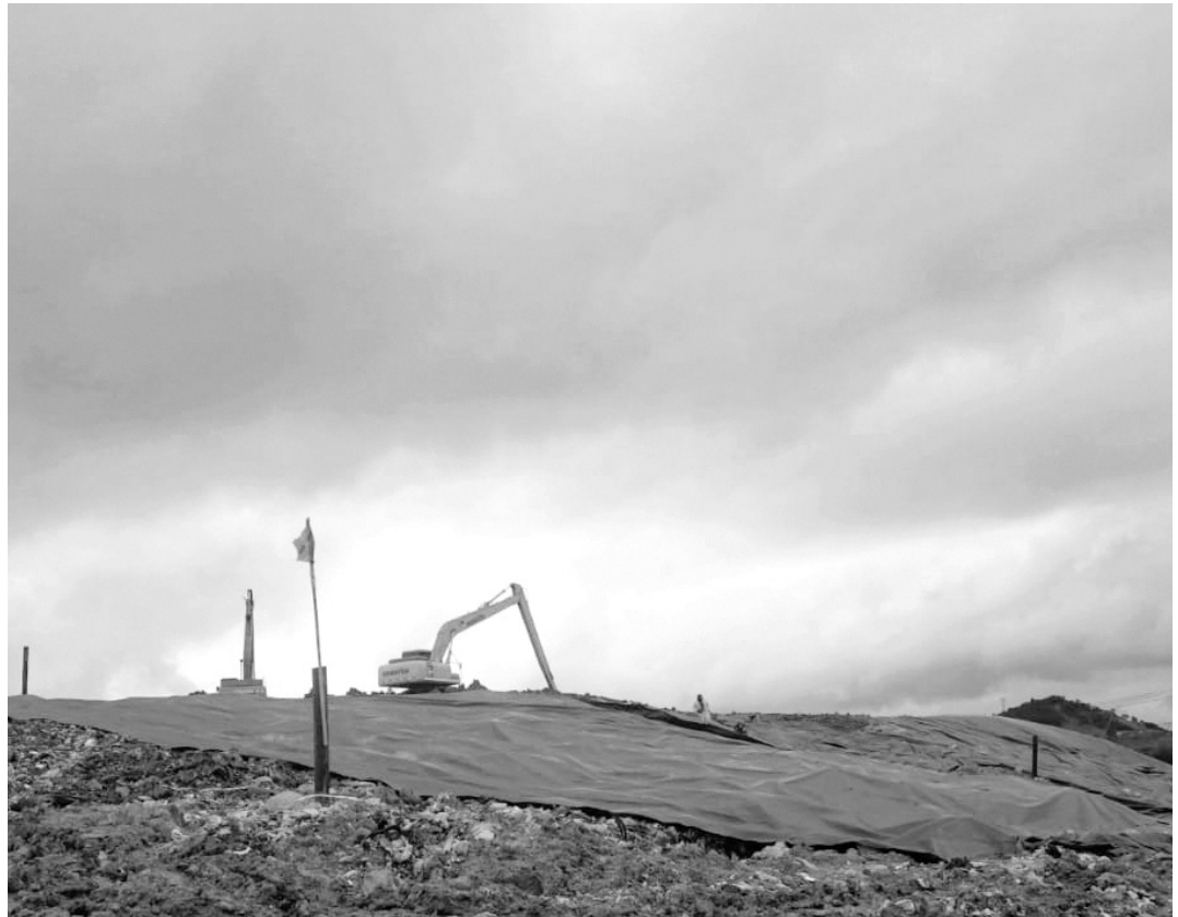
» Instalación de geomembrana con termosellado.
