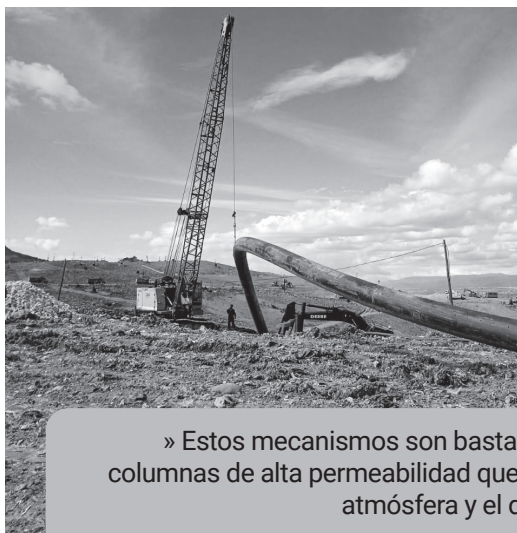
» 2. Perforaciones dirigidas, extrayendo mayor volumen de lixiviado.
